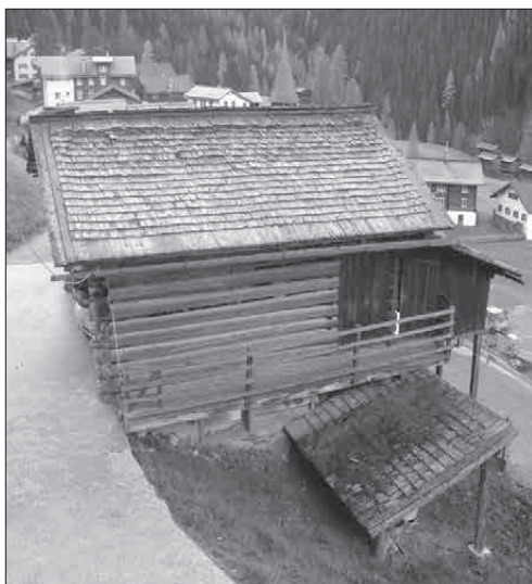
Stall Hoffmann vor der Sanierung ...
