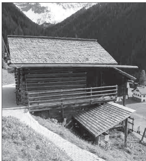
... und mit dem neuen Schindeldach.
