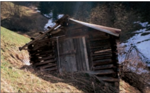
Vor der Sanierung: die Heulege der Fraktions- gemeinde in der Schluocht.
