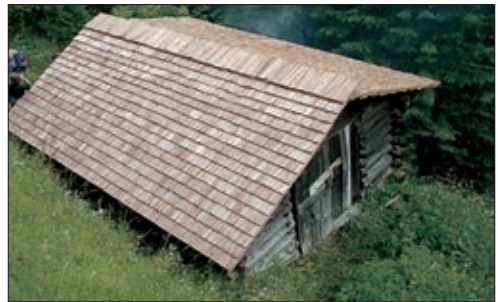
So präsentiert sie sich mit dem neuen Schindeldach.
