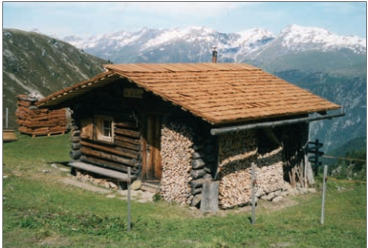
Die Hirtenhütte Fanez der Oberalpen genossenschaft bekam ein neues Dach aus handgespaltenen Schindeln.
