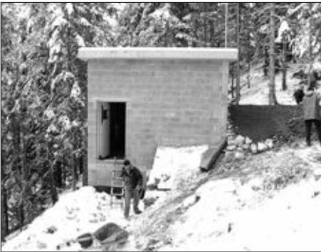
Reservoir mit neuem Schieberhaus
