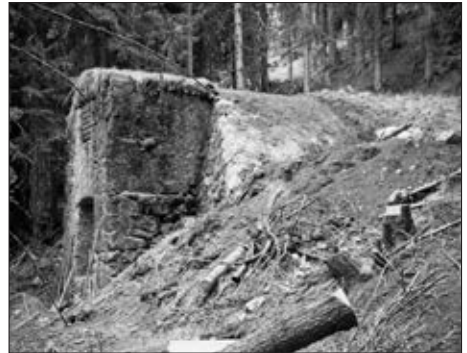
Reservoir mit altem Schieberhaus
